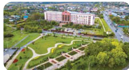
Вид сверху на здание высшего учебного заведения Находкинского филиала ВГУЭС в районе улицы Озерной и Морской сквер возле него.
