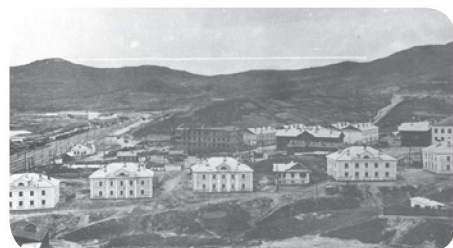
Строительство мореходного училища. Район 2-го участка, улица Зои Космодемьянской. фото Прихода И.Д., [1950] год. Архивный отдел администрации Находкинского городского округа. Фонд Р-123, опись 1, дело 36.
