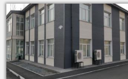
Введено ООО «ТК Русские транспортные линии» Строительство логистического бизнес центра для предоставления логистических услуг
