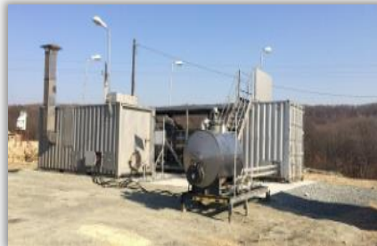
Введено ООО «ЭкоТехПрим» Создание компании по сбору, транспортировке и обезвреживанию отходов 3-4 класса опасности на территории Приморского края
